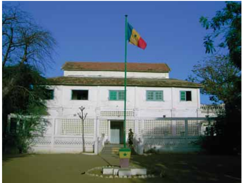
Bâtiment colonial abritant la Gouvernance de Matam
